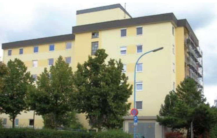
Sanierung Parkstraße 51 - eine halbherzige Lösung! Nur neu anstreichen und Rolläden einbauen, macht noch keinen Gewinn für die Mieter! Ohne Wärmedämmung ist ein Haus aus 1982 wärmetechnisch nicht zu sanieren!
